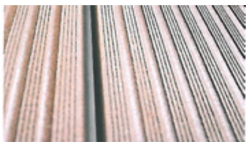
Pohled shora na spáru s hadicovým těsněním
